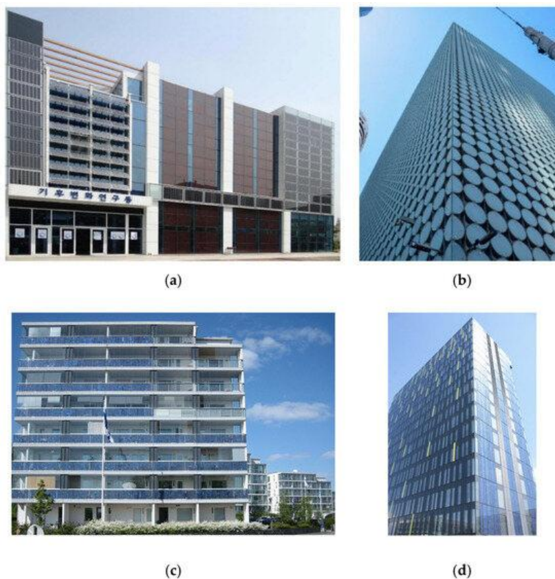
Kuva 2. Esimerkkitapoja käyttää aurinkopaneeleja rakennuksien julkisivuissa. Kuvan a-kohdassa on rakennukseen integroitu eri värisiä aurinkopaneeleja. B-kohdassa on aurinkopaneelit ovat integroitu julkisivuun ja c-kohdassa parvekkeiden kaiteisiin. Kuvan d-kohdassa aurinkopaneelit ovat integroitu osaksi julkisivun ulkokuorta. Kuva tekijöiltä Hamidi et al. [10]. Tekijänoikeus 2025 Hamidi, julkaisija Architecture.
