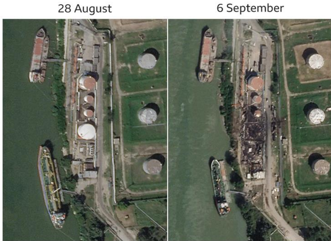
Kuva 30 Satamainfrastruktuurin vaurioita Renin satamassa syyskuussa 2023
