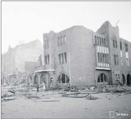
Kotkan työväentalo (nyk. konserttitalo) jatkosodan pommitusten jäljiltä heinäkuussa 1941. Pahoin vaurioitunutta rakennusta jälleenrakennettiin 1940-luvun lopulta 1950-luvulle.
