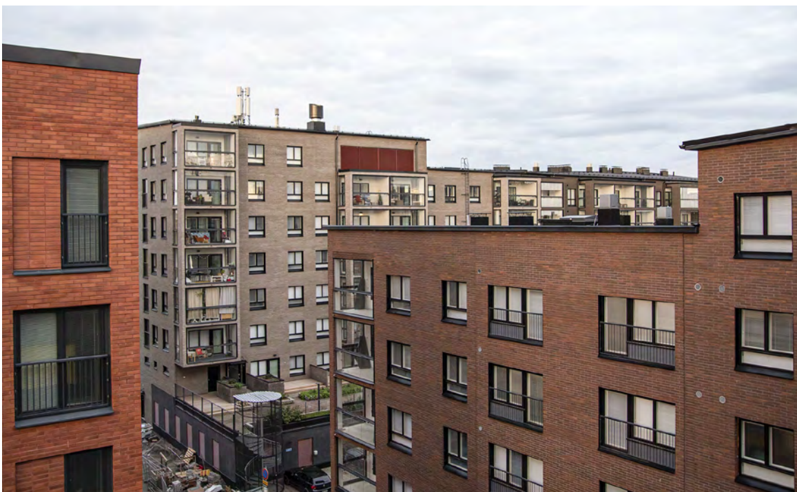
Kuva 1. Herttuankulman kattoja. Kuva: Päivi Leinonen
