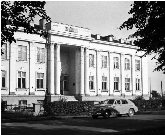
Figure 5. La maison du Bureau du Film à Chaussée de Narva. 1954, la photo par V. Gorbunov.
