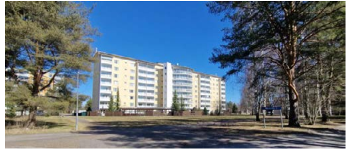
Alahangantie 2: Rakennettu 1974 Alahangantie 8: Rakennettu 1971
