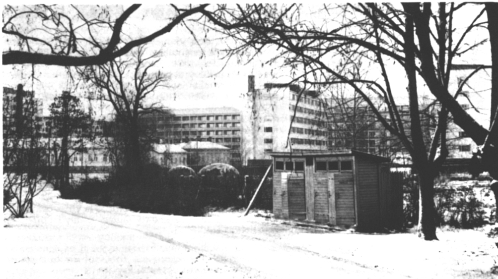
Kuva 5. Kupittaaan käymälät. Kuvalähde 96-lehti 3/1971.
