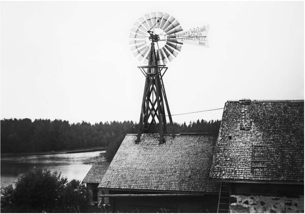
Pitkänpellon tilalle vuonna 1908 asennettu tuulimoottori lienee ollut ensimmäinen Pohjois-Karjalassa. Tuulivoiman avulla nostettiin vettä navettaan vasemmalla näkyvästä Pitkälammesta. Valokuva Onni Puhakka 1914/OPpk.
