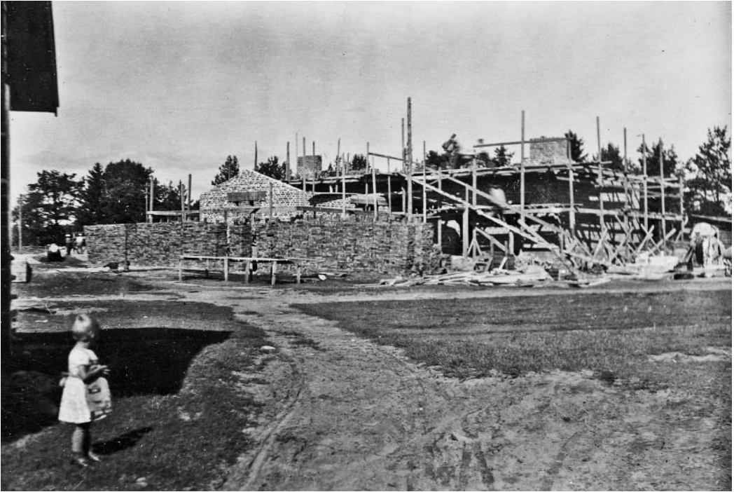
Taipaleen osuuskaupan myymälä rakenteilla 20.8.1932. Taipaleen myymälän toiminta laajeni niin voimakkaasti, että vasta viitisentoista vuotta toimittuaan se joutui muuttamaan jo kolmanteen, entistä suurempaan kauppahuoneistoon. Valokuva Onni Puhakka/OPpk.
