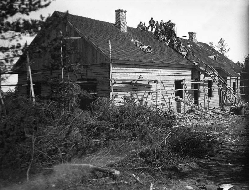
Käsämän kylän kansakaoulu rakenteilla vuonna 1927. Valokuva Onni Puhakka/OPpk.
